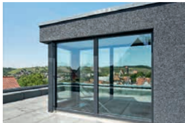
Die Treppe auf die Dachterrasse endet im Glasaufbau. Bei Schlechtwetter kann man die Aussicht auch hinter den Wärmeschutzfenstern genießen.
