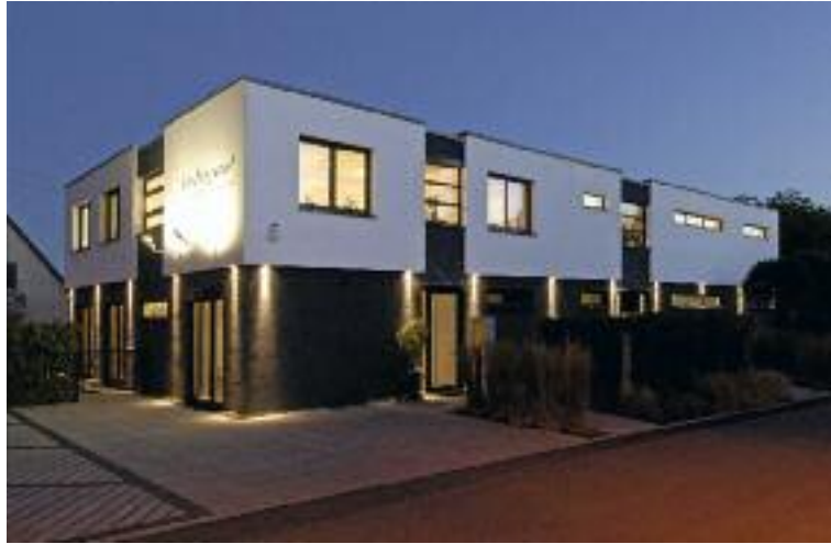
Große Fenster im Osten, schmale Fensterbänder im Westen, wo sich der Wohnteil von der Straße abschottet.
